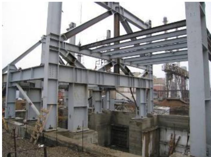
Základové konstrukce kmenárny - realizace
