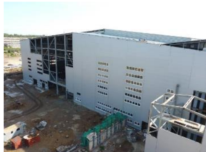
Výrobní monoblok (Hutní hala)
