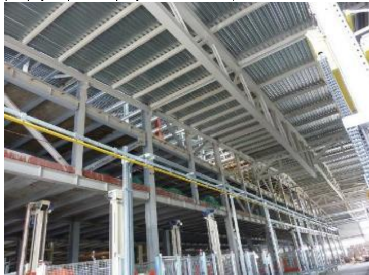
Výrobní monoblok (Hutní hala)
