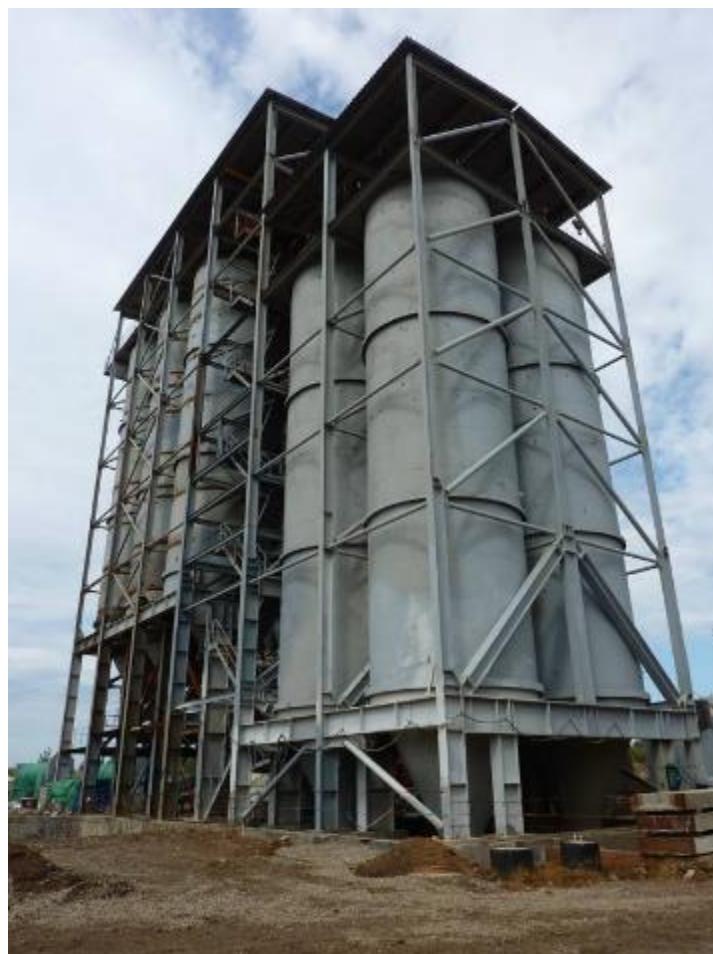
Ocelová konstrukce kmenárny
