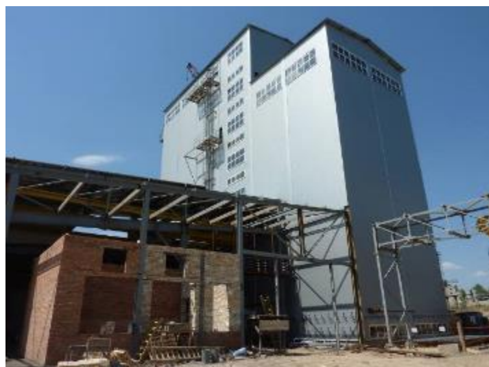
Opláštěná kmenárna a sklad big-bagů
