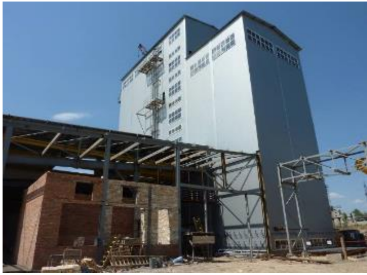
Блок бункеров в обшивке и склад мягких контейнеров
