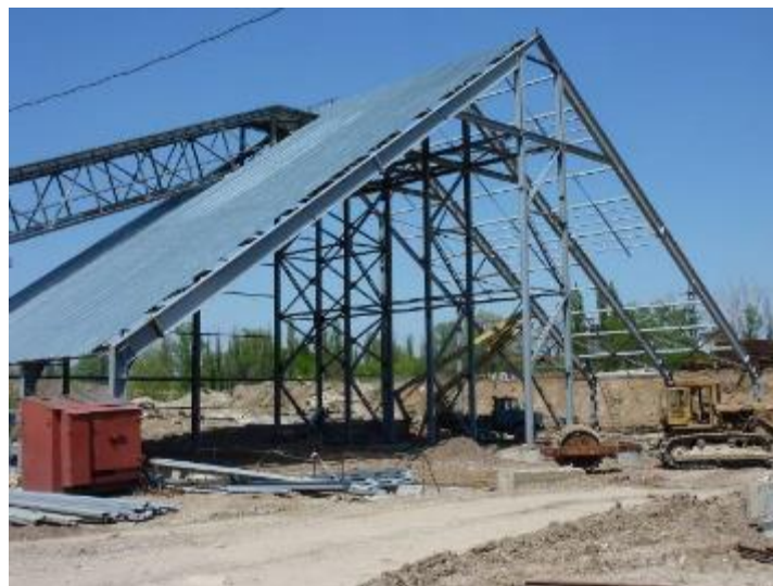
Склад песка - возведение
