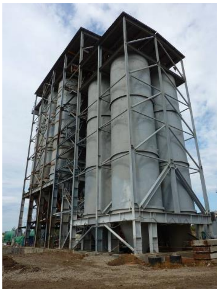
Стальная конструкция бункеров для компонентов шихты
